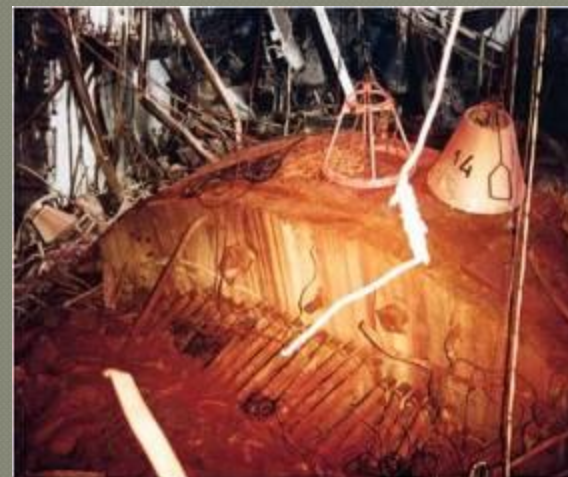
Крышка реактора после взрыва
