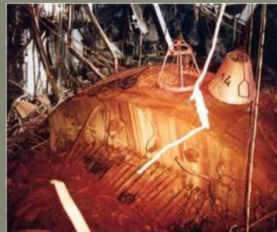
Крышка реактора после взрыва
