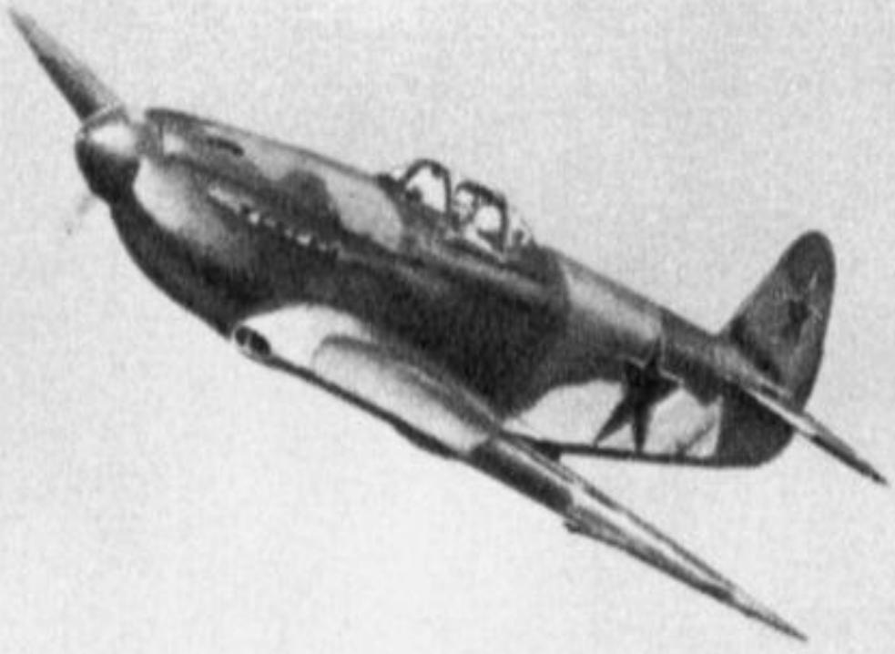
Серийное производство трёх пушечного Як- велось в Саратове и Тбилиси с весны 1945 г. по лето 1946 г. Вооружение самолета состояло из мотор пушки Б-20М и двух синхронных Б-20С. Еще одной попыткой увеличить огневую мощь истребителя стал Як с одной Н-37 в развале блока цилиндров и двумя синхронными Б-20. Основную часть работ по Як кончили к концу мая 1945 г. и, в связи с окончанием войны, доводить этот вариант не
