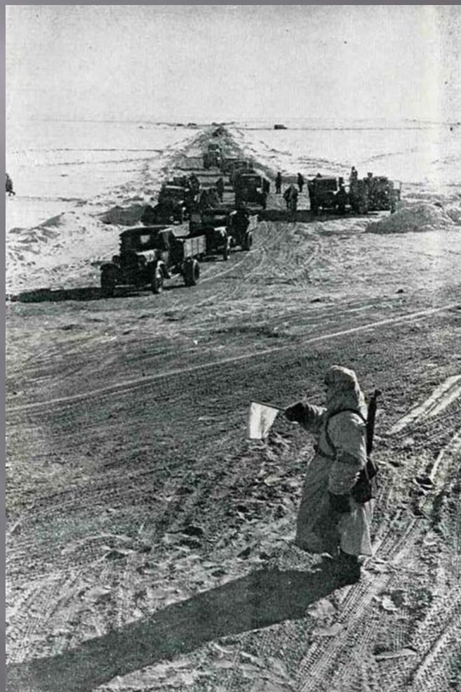
Дорога состояла из двух кольцевых трасс, каждая из которых имела два отдельных направления движения – для грузового движения (в город) и для порожняка или эвакуации (из города).
