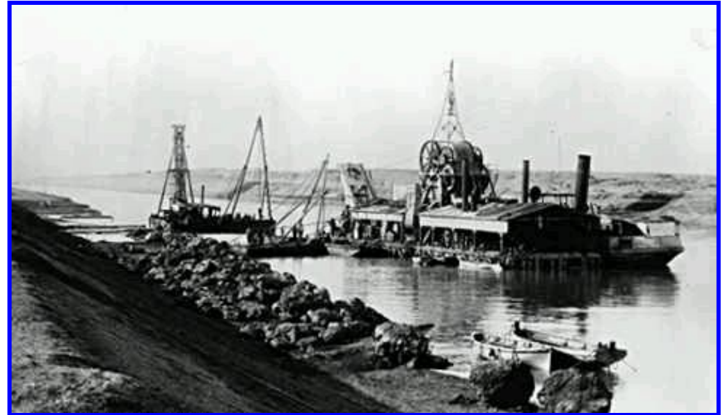
Строительство Суэцкого канала
