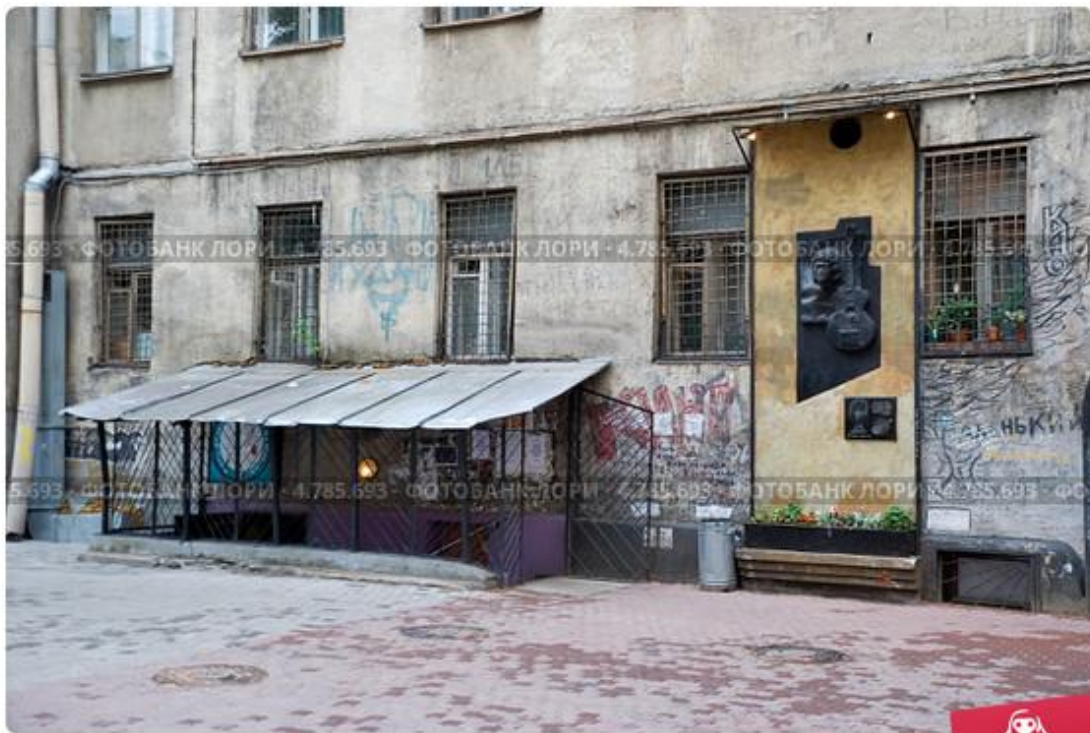
Котельная "Камчатка". Санкт-Петербург
