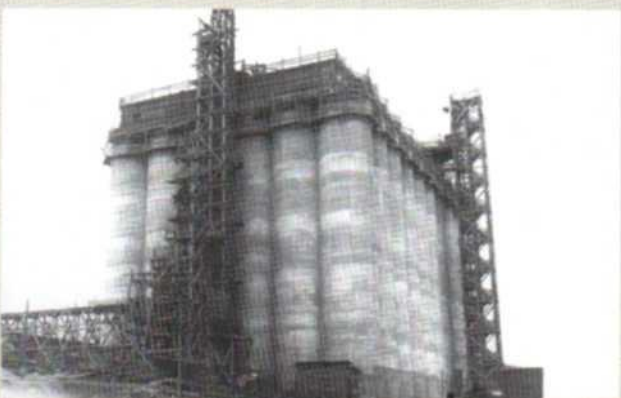
Загальний вигляд будівництва великого елеватора. Херсон. 1932-1933 рр.
