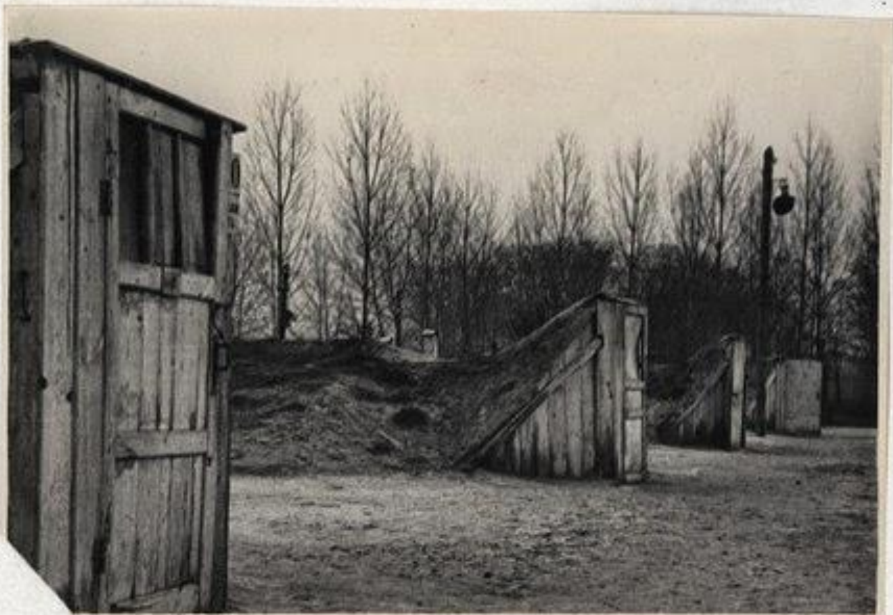
Сырецкий лагерь. Вход в землянки, где жили заключенные.
