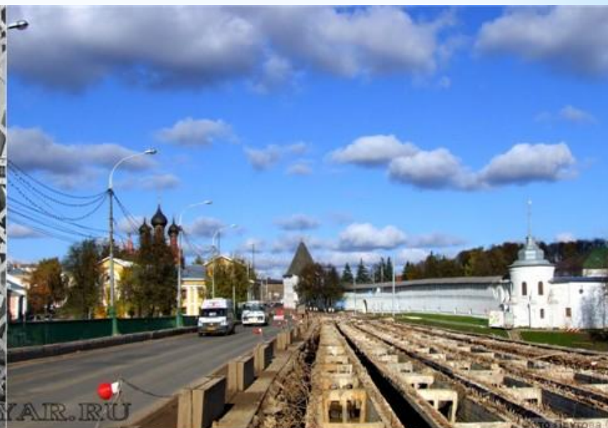
Реконструкция моста через реку Которосьль.
