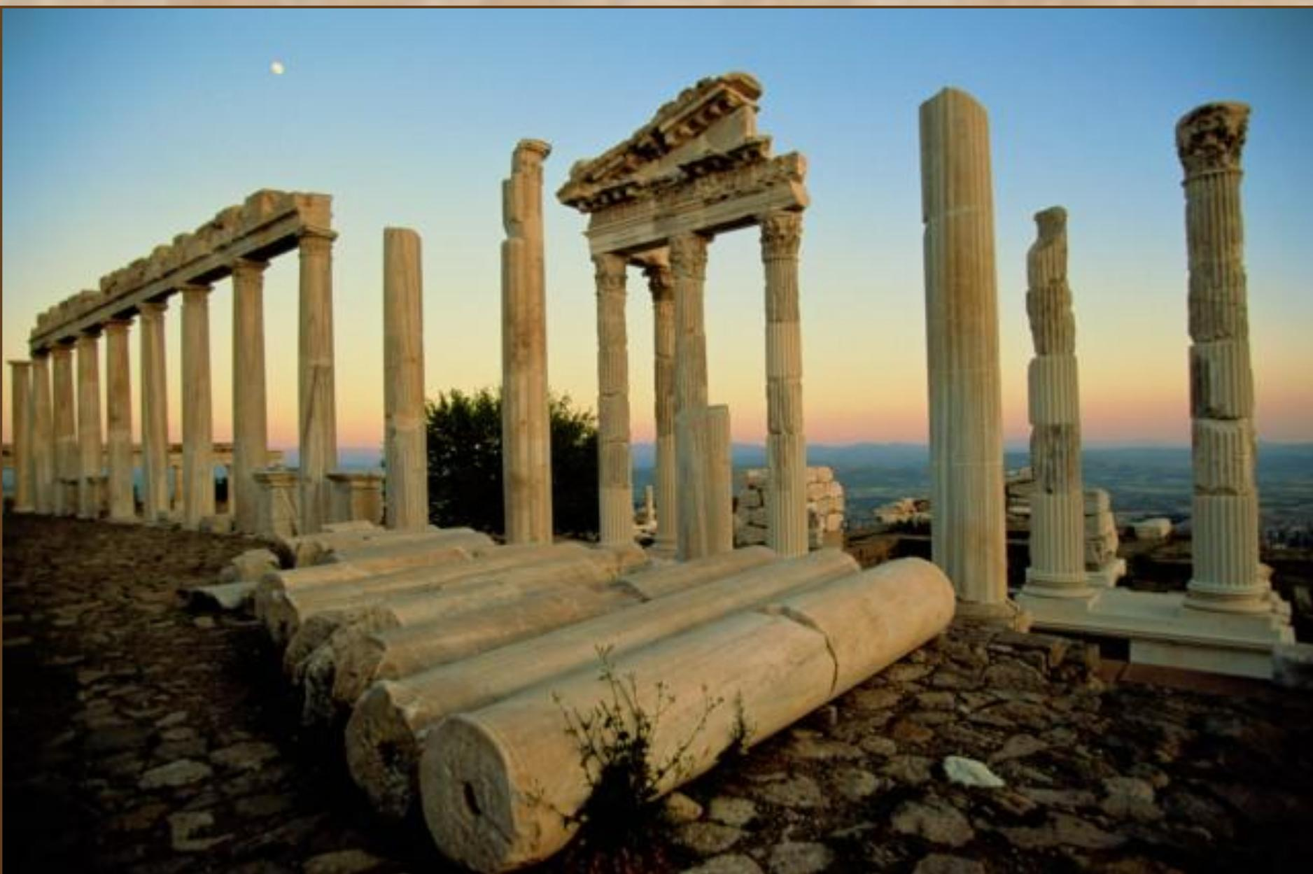
**Конструкция из стоек и балки, лежащей на них,
