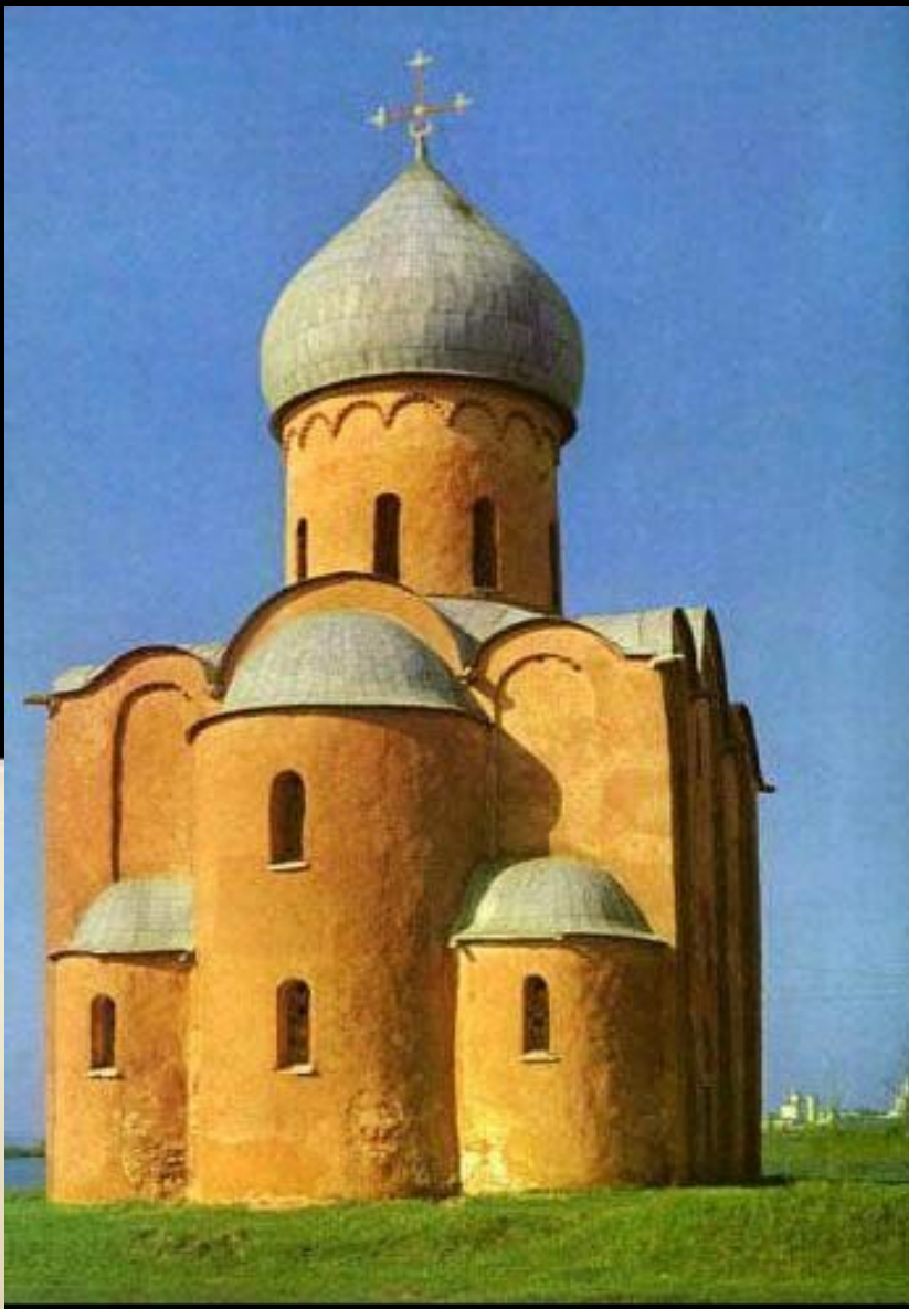
Церковь Спаса на Нередице. Новгород 1189 – 1199 г.г.
