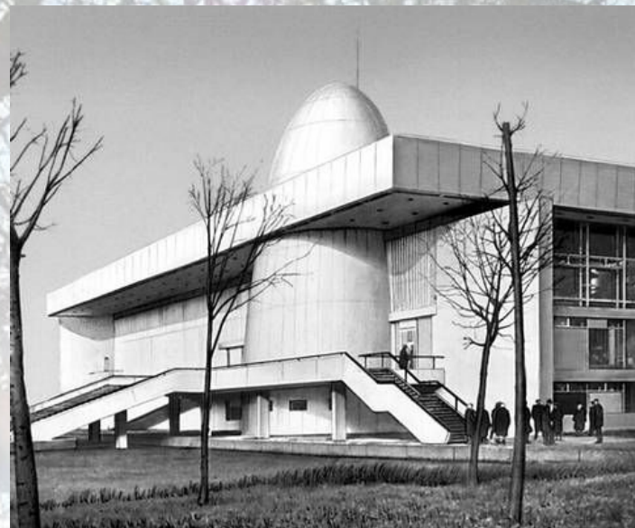
здание Музея истории космонавтики им. К.Э. Циолковского в Калуге
