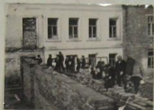
Пионеры на строительстве спортивного зала школы
