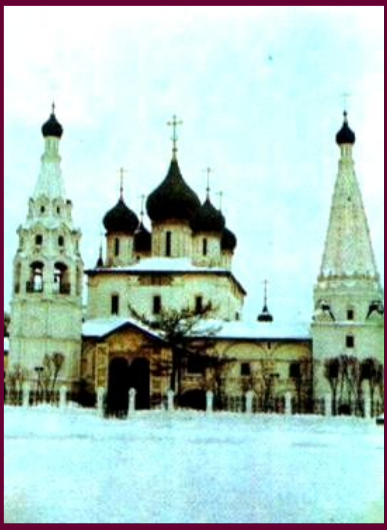
Церковь Ильи Пророка В Ярославле
