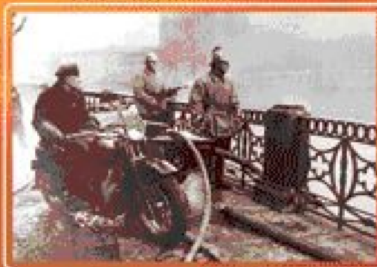
■ Пожарный мотоцикл в блокадном Ленинграде.
