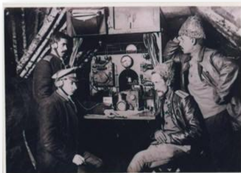
Военно-полевая искровая радиостанция 1910 г
