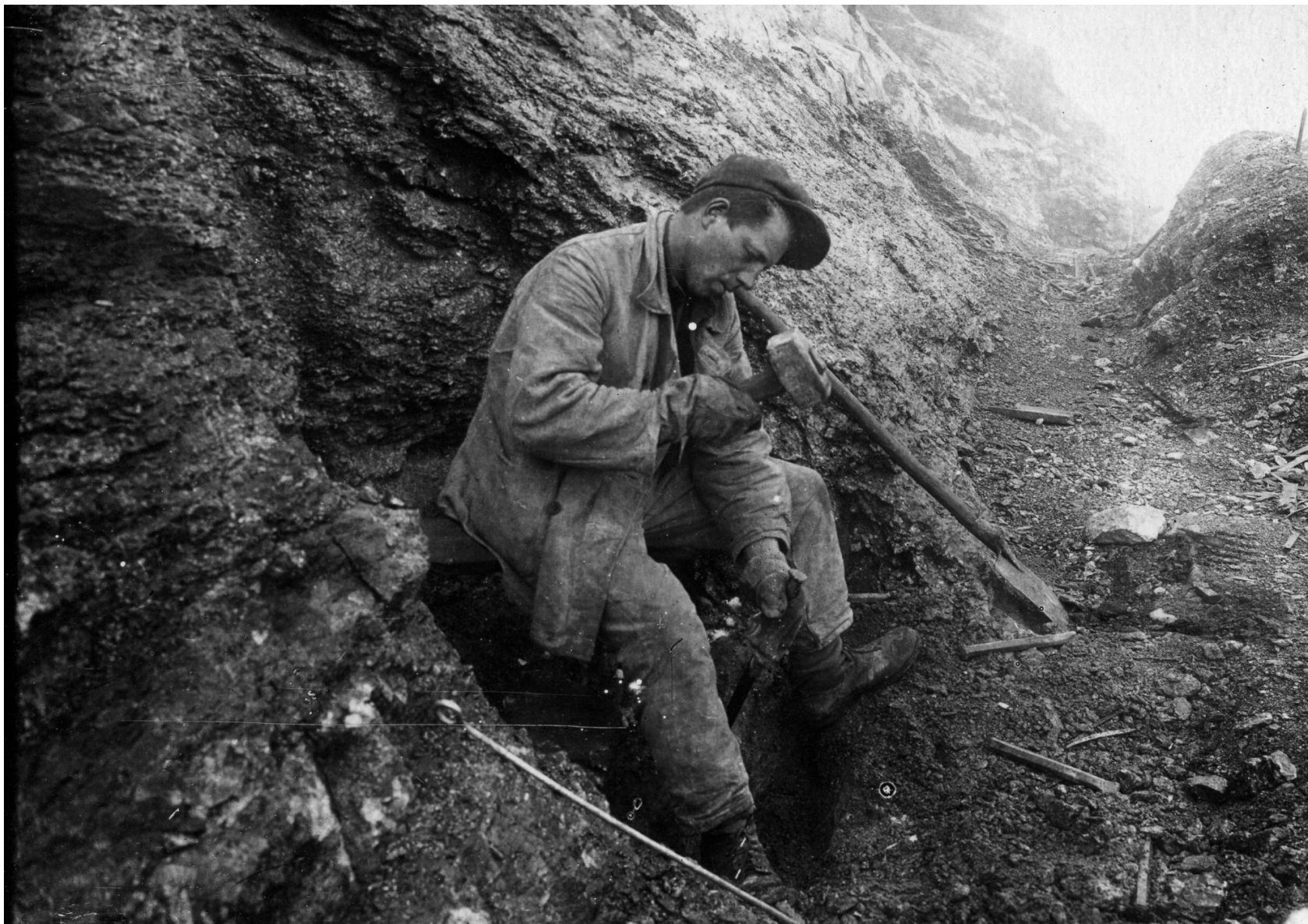
Ручное бурение негабаритов на открытом руднике имени С.М. Кирова. 1931 г.
