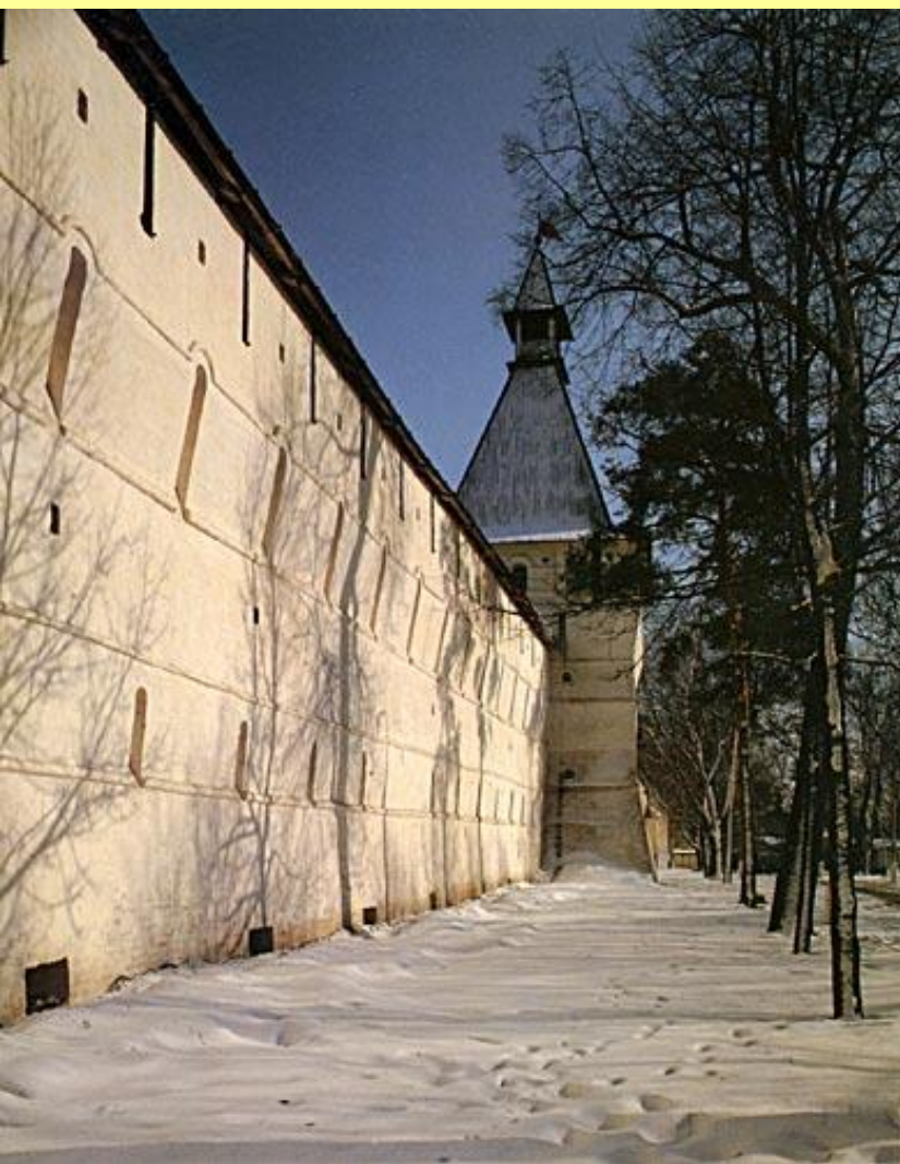
Стена и Сушильная башня Троице-Сергиева монастыря
