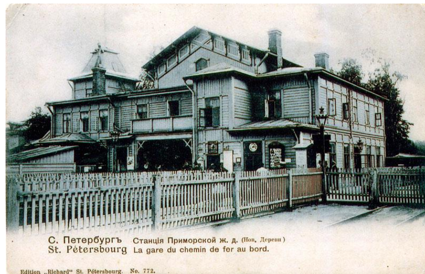
Ж-д станция Новая Деревня
