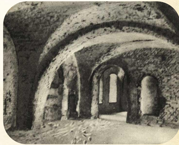
Казематы в разрушенных казармах
