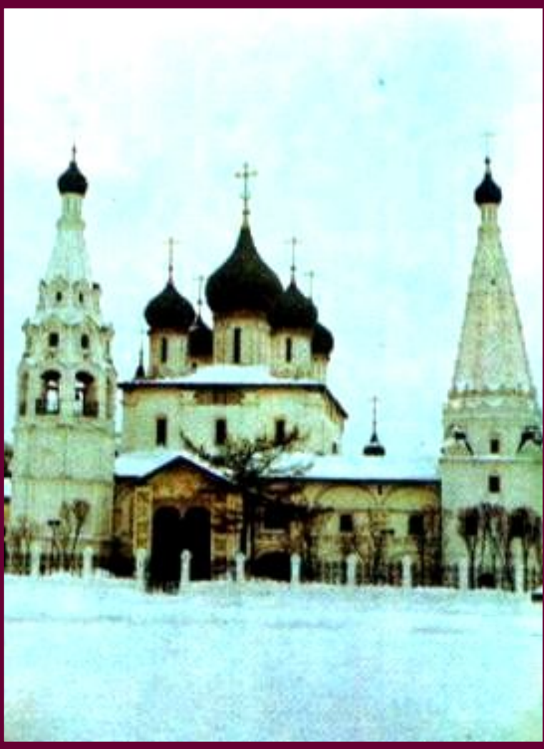
Церковь Ильи Пророка В Ярославле
