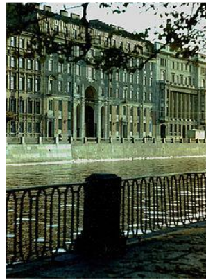
Толстовский дом, ул. Рубинштейн а, дом 15-17
