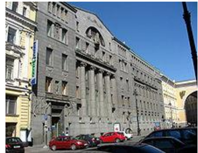
Бывшее здание Азовско- Донского банка на Б. Морской ул. в Санкт- Петербурге
