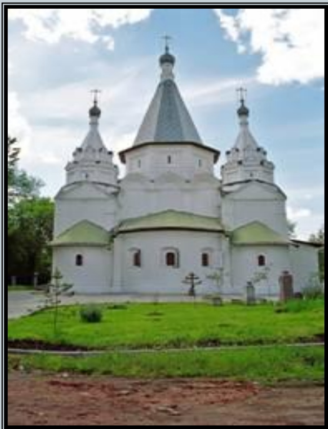
Церковь Троицы Животворящей в Троицком-Голенищеве (1644-1645 )
