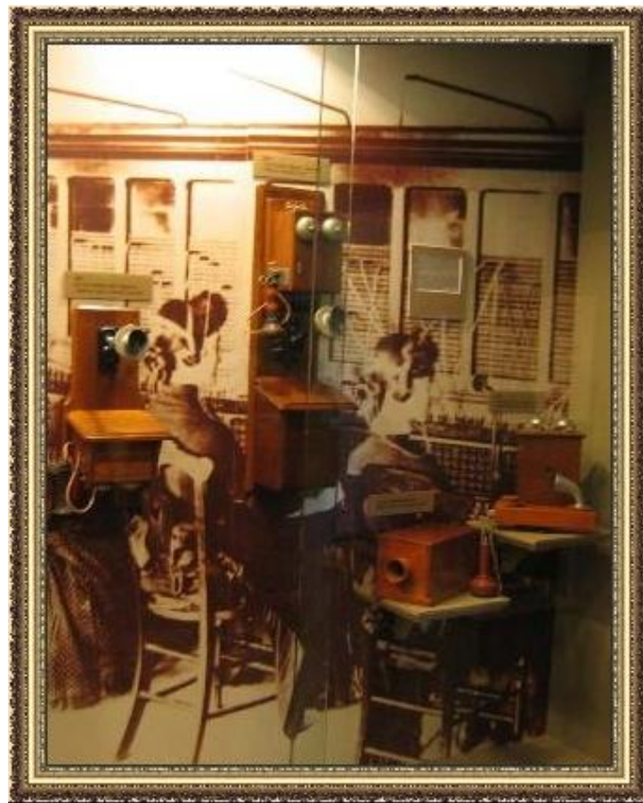
На телефонной станции. Начало XX века
