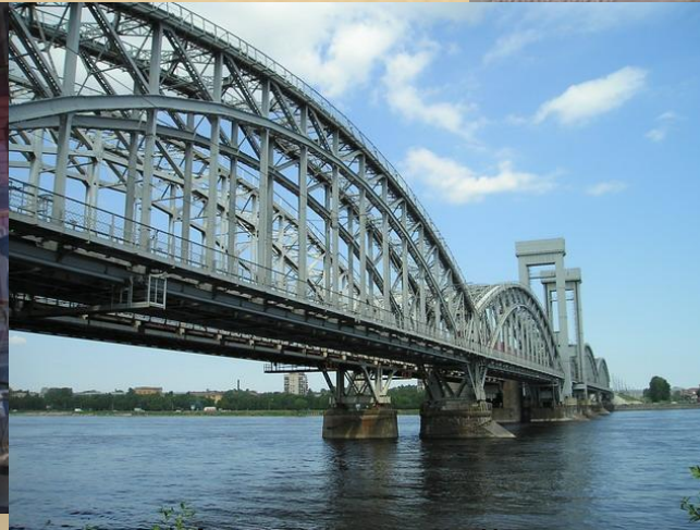
Финляндский железнодорожный мост
