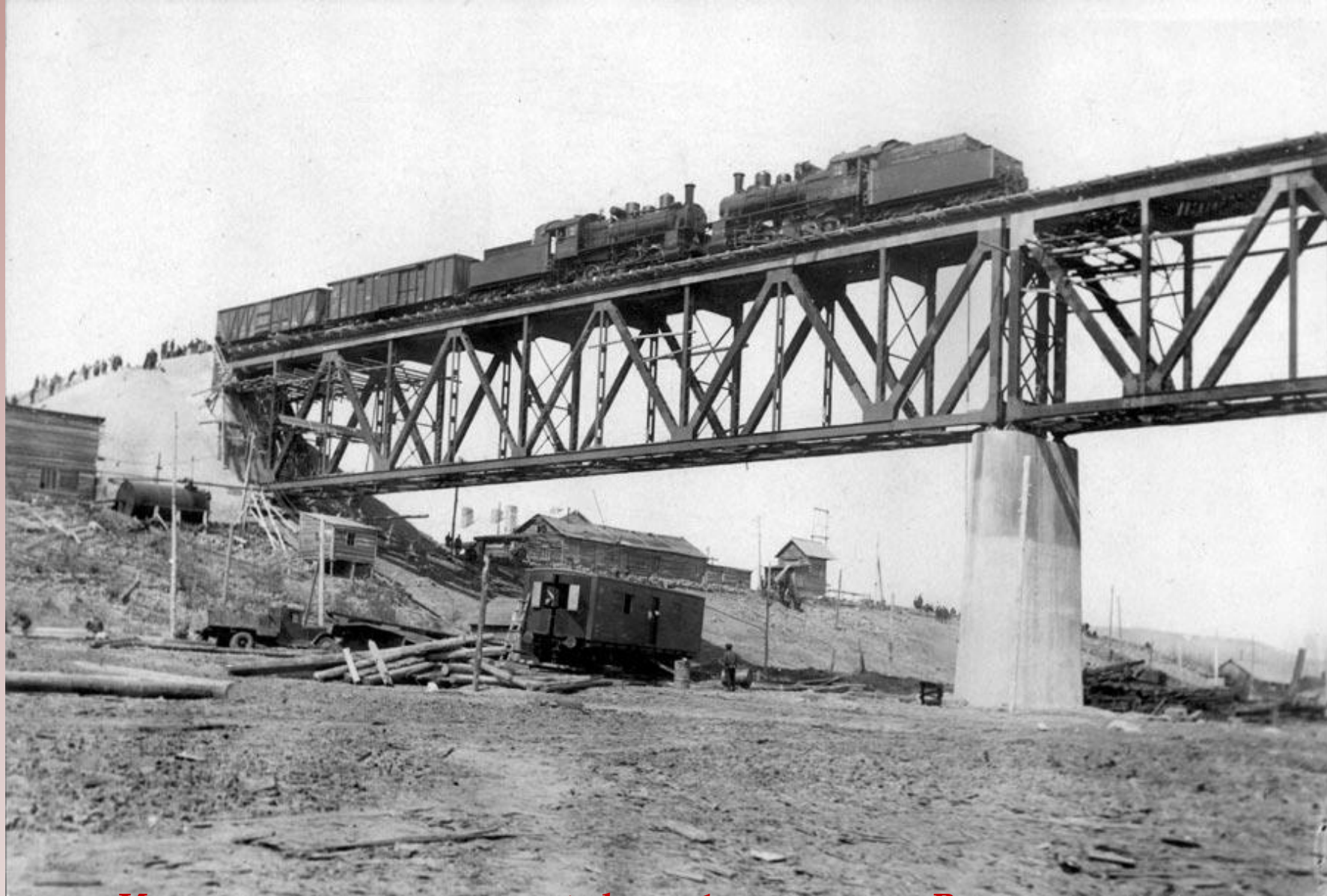
Испытание под нагрузкой ферм 1-го пролета. В качестве нагрузки используются 2 паровоза и груженые вагоны Фото из фондов музея Приволжской железной дороги
