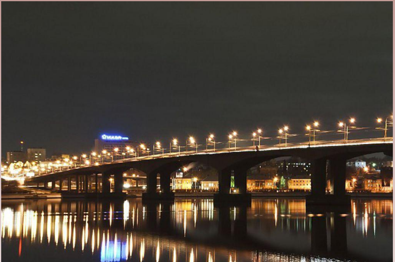
Кострома мост через реку Волгу.
