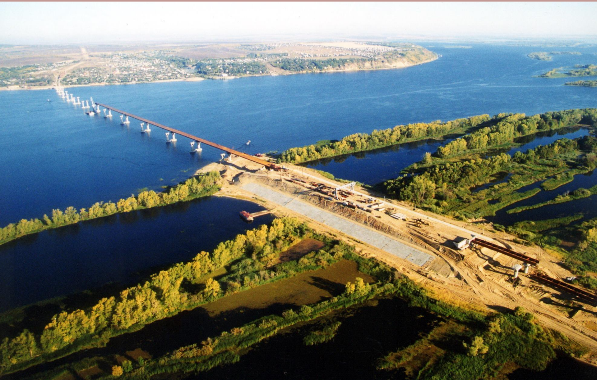
Строительство моста у Пристанного в самом начале.
