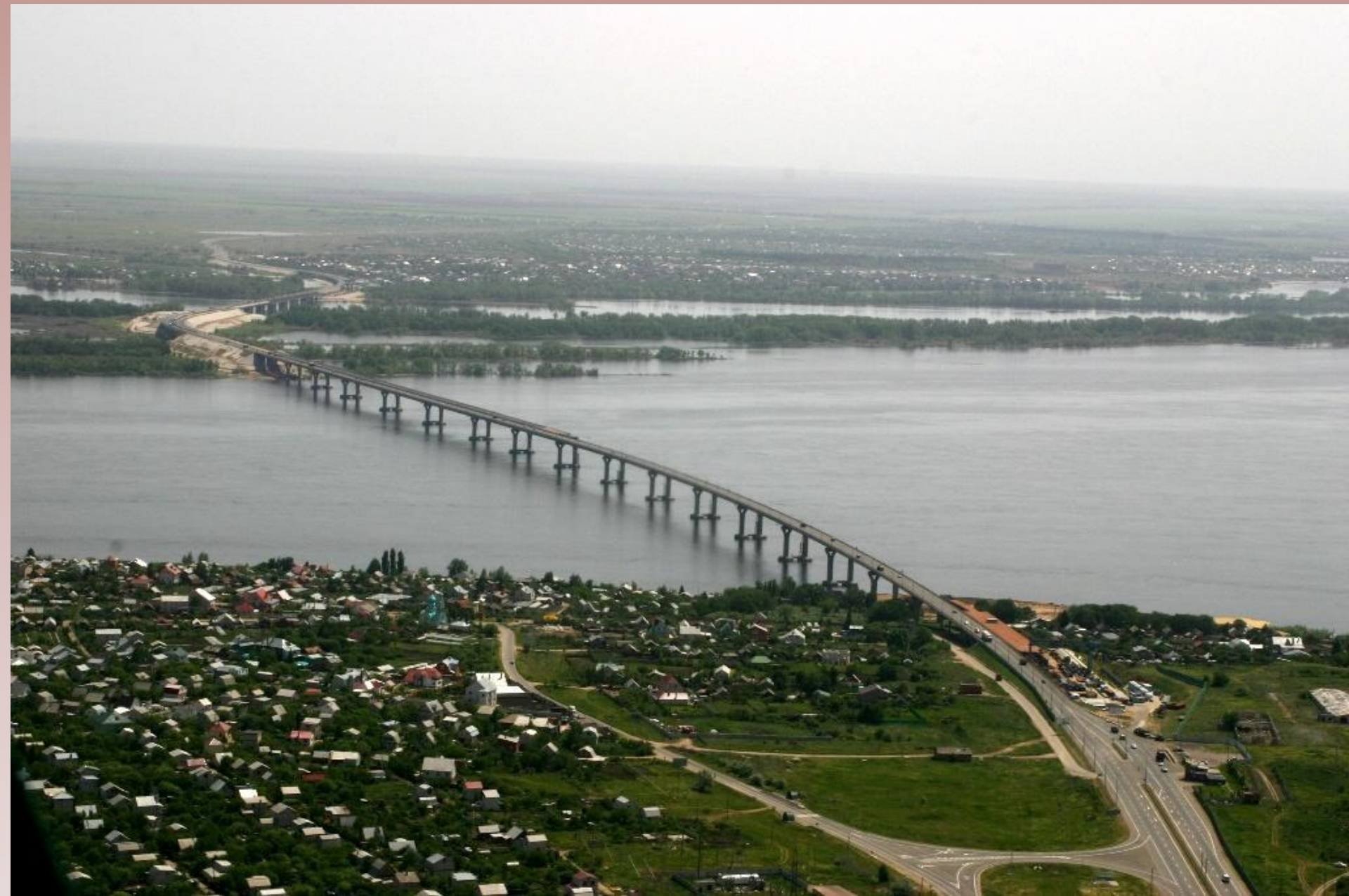
Мост перед открытием
