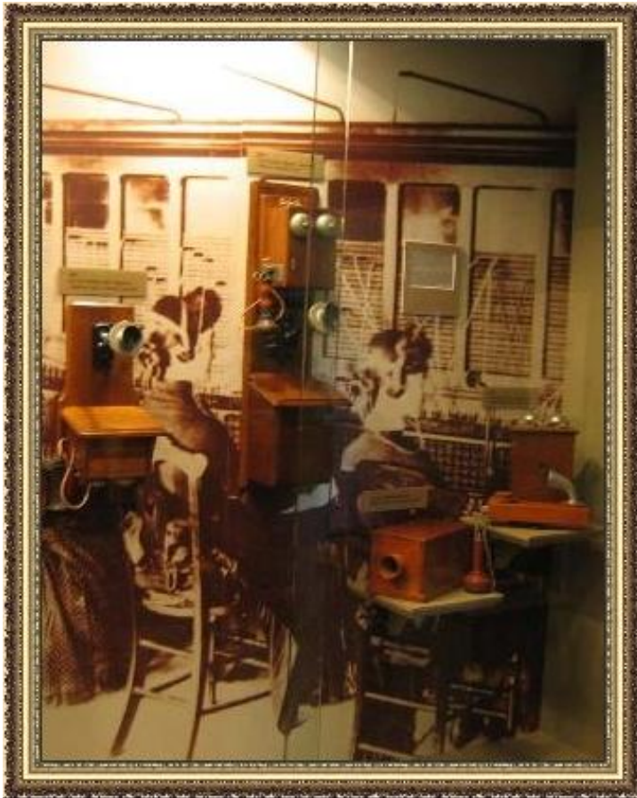
На телефонной станции. Начало XX века
