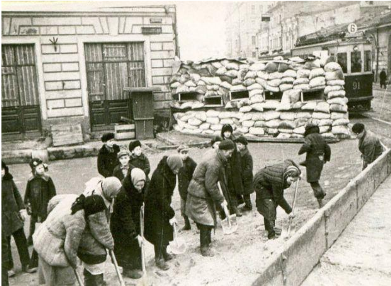
Москвичи на строительстве баррикад на окраине города
