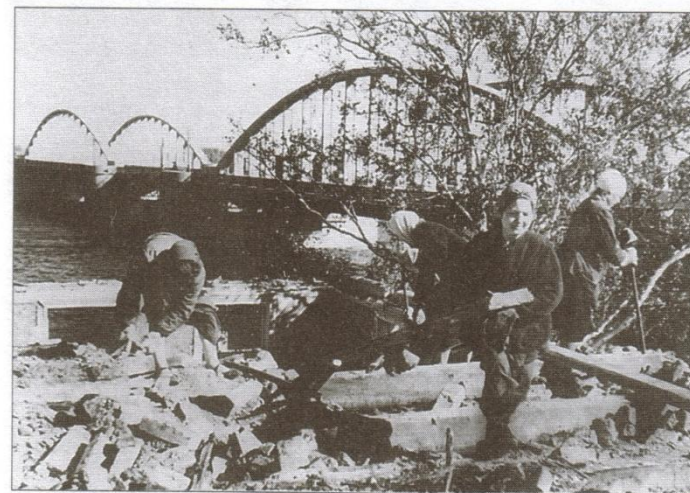
Разборка деревянного дома у Володарского моста после обстрела
