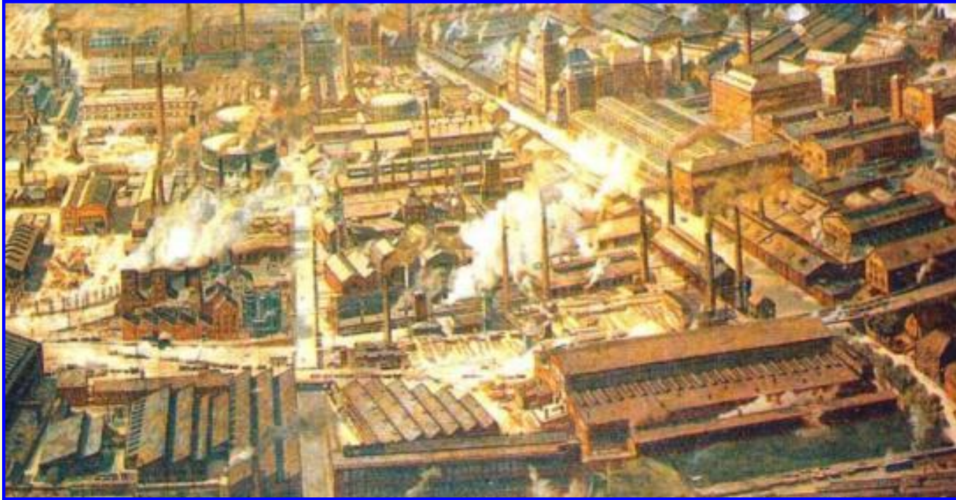
Металлургический завод в Эссене
