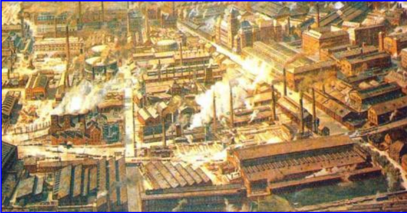
Металлургический завод в Эссене
