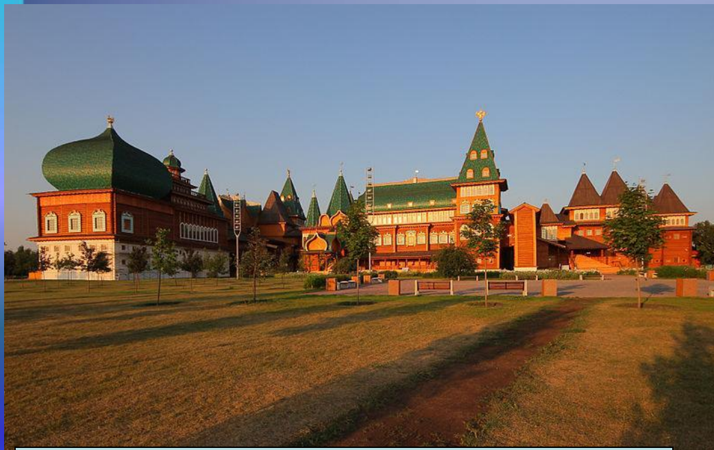
Дворец после реконструкции
