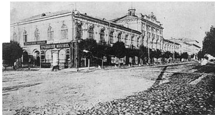
Здание Тверской Городской Управы
