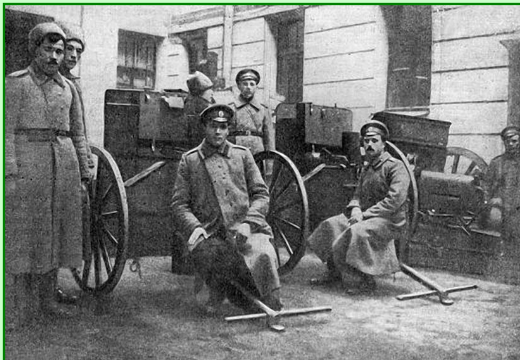
Юнкеры на охране телефонной станции. Петроград осень 1917 г.
