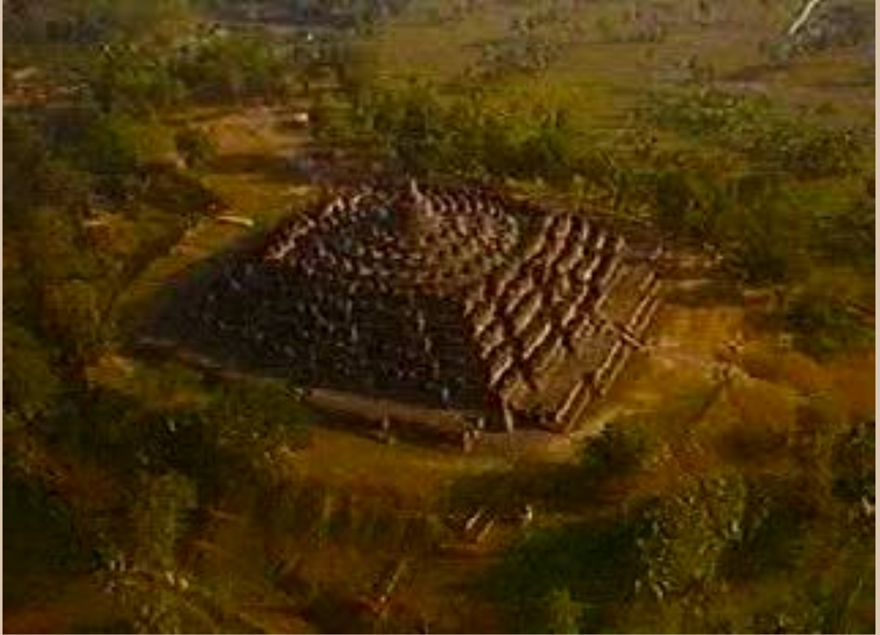
Боробудур — буддийский храмовый комплекс на о. Ява
