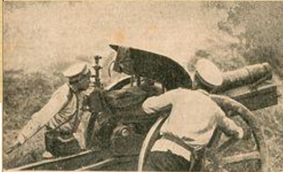
Батарея на позиции.
