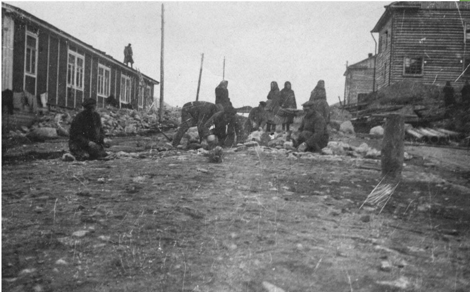
Мощение Обогачительной улицы. 1932 г.
