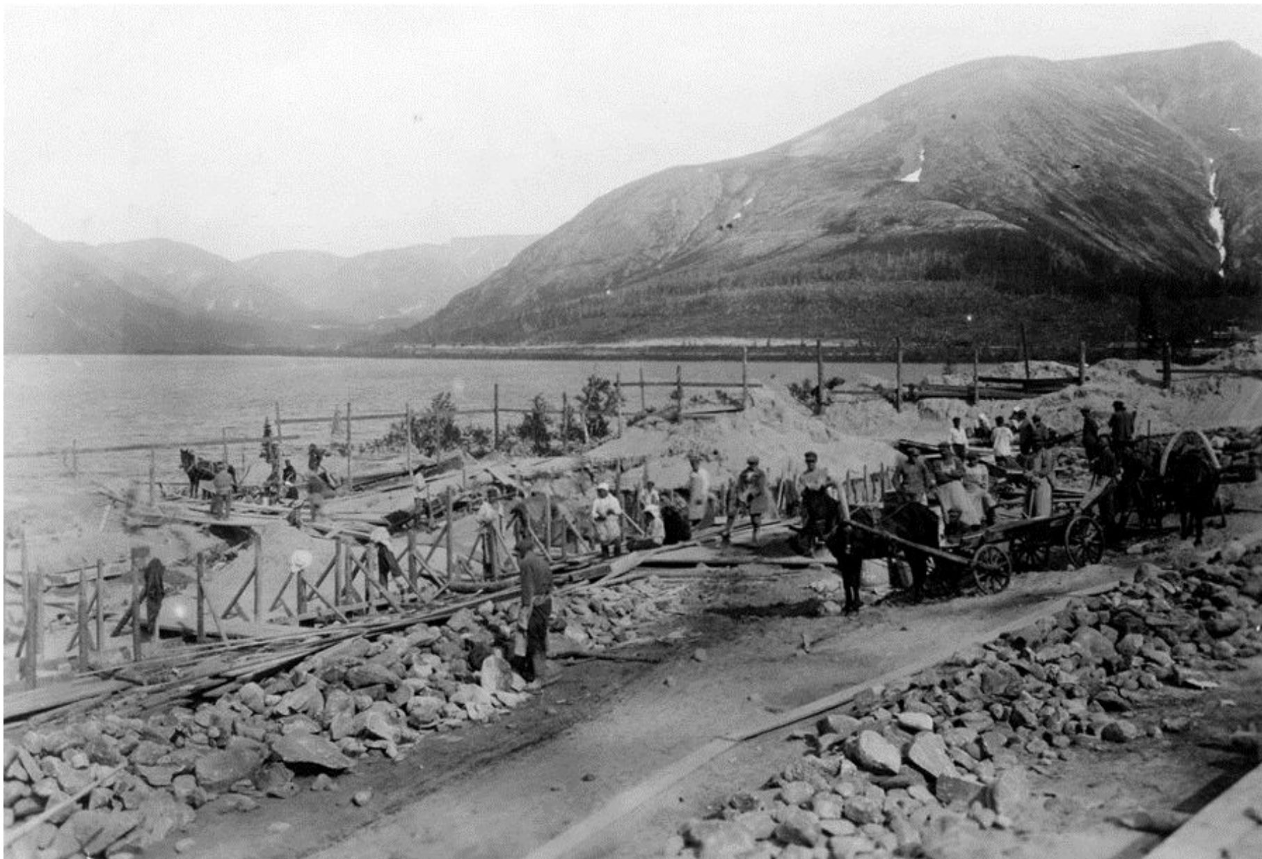
Строительство электростанции. 1930 г.
