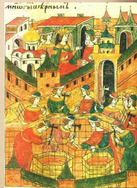
Строительство Храма Василия Блаженного (Покрова на Рву) на Красной площади
