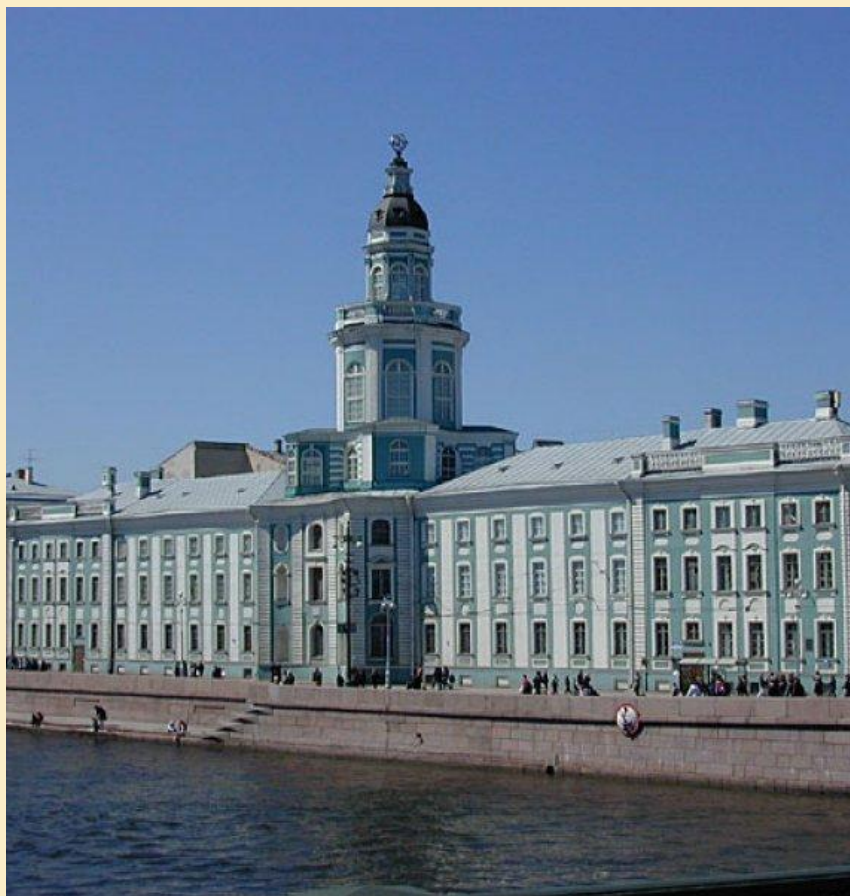
Здание Кунсткамеры С-Петербург, Университетская наб., д.3
