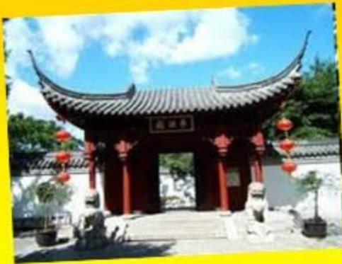
Главная тяжесть в конструкциях зданий древнего Китая ложилась на столбы каркаса, поддерживающие крышу, а не на стены.
