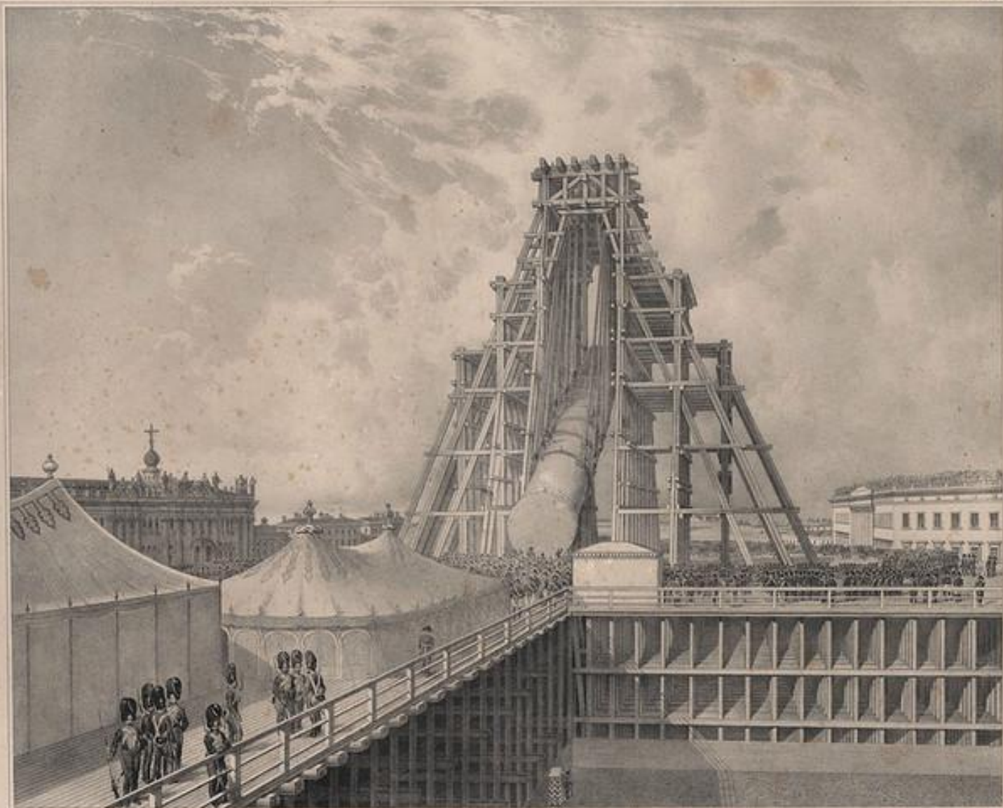
Vue de l'érection de la Colonne.
