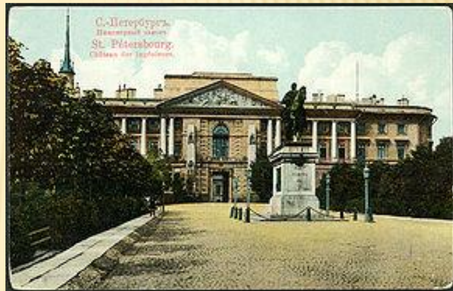
Южный (главный) фасад (со стороны площади Коннетабля)
