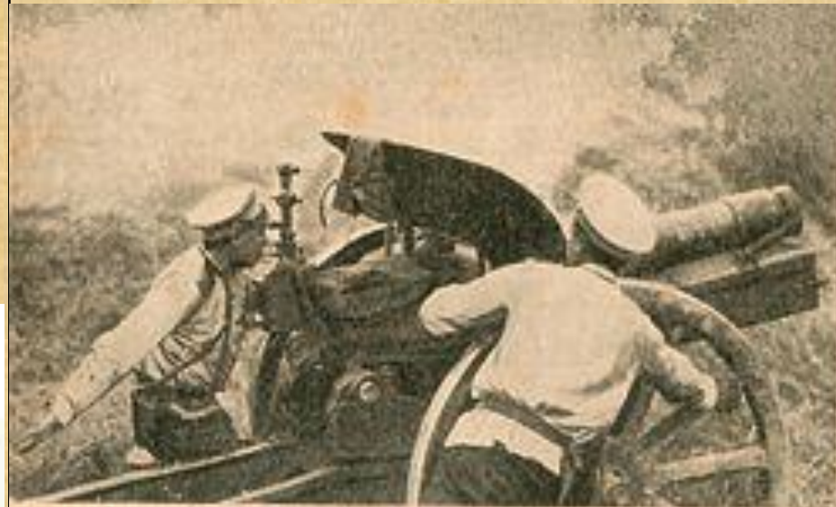
Батарея на позиции.
