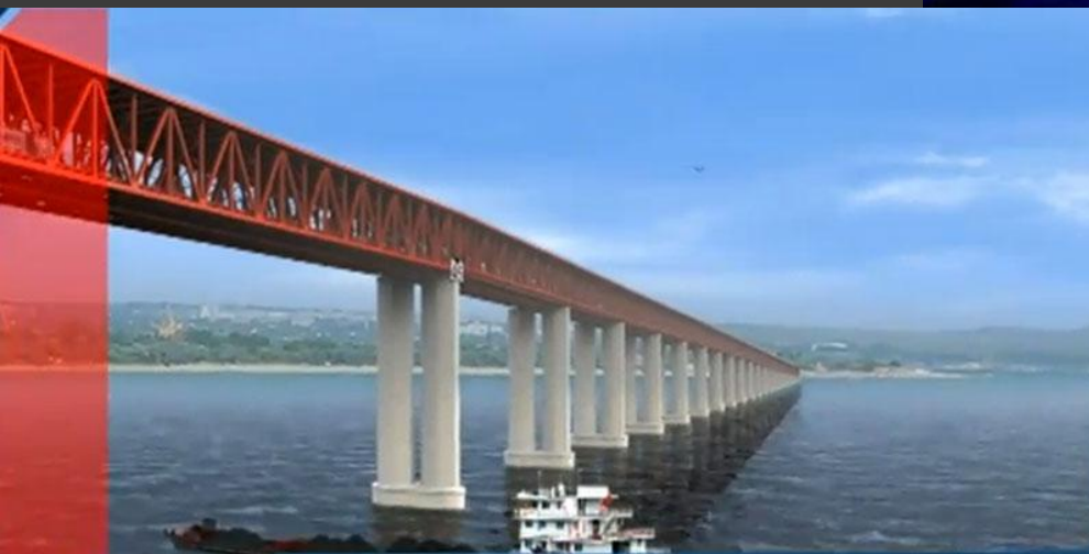
Мост через Керченский пролив
