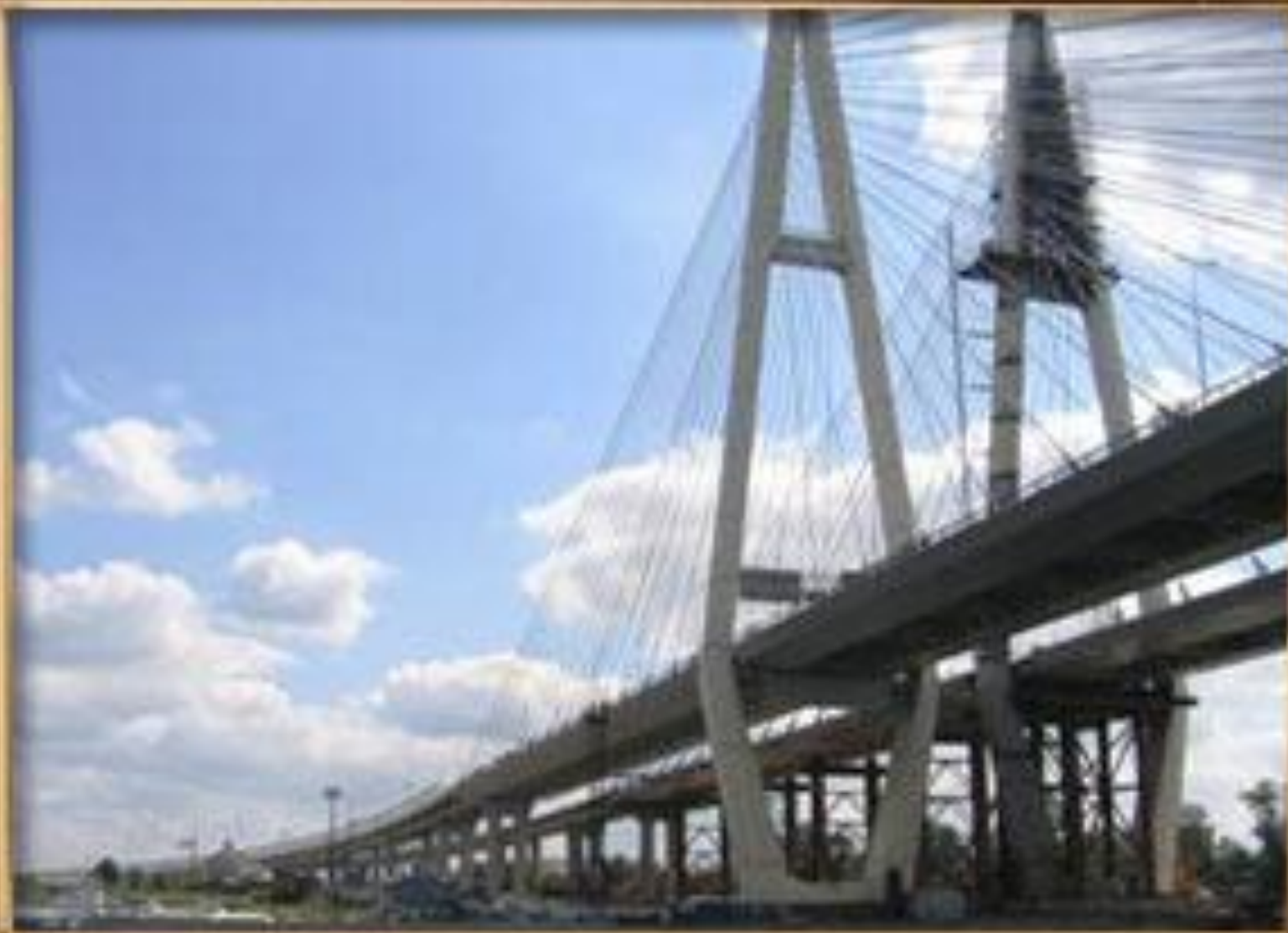
Большой Обуховский мост
