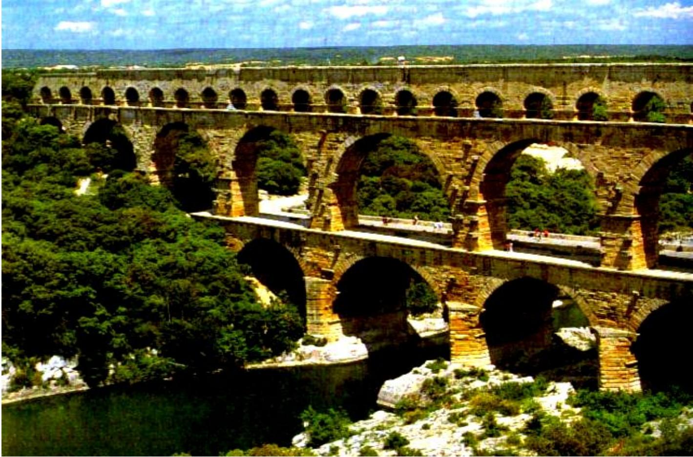
Для снабжения Рима водой строили водопроводы. Акведук - каменная труба, или кладка для подачи воды. Чтобы вода текла самотеком строились арочные опоры - виадук - арочный мост через реку, или ущелье.
