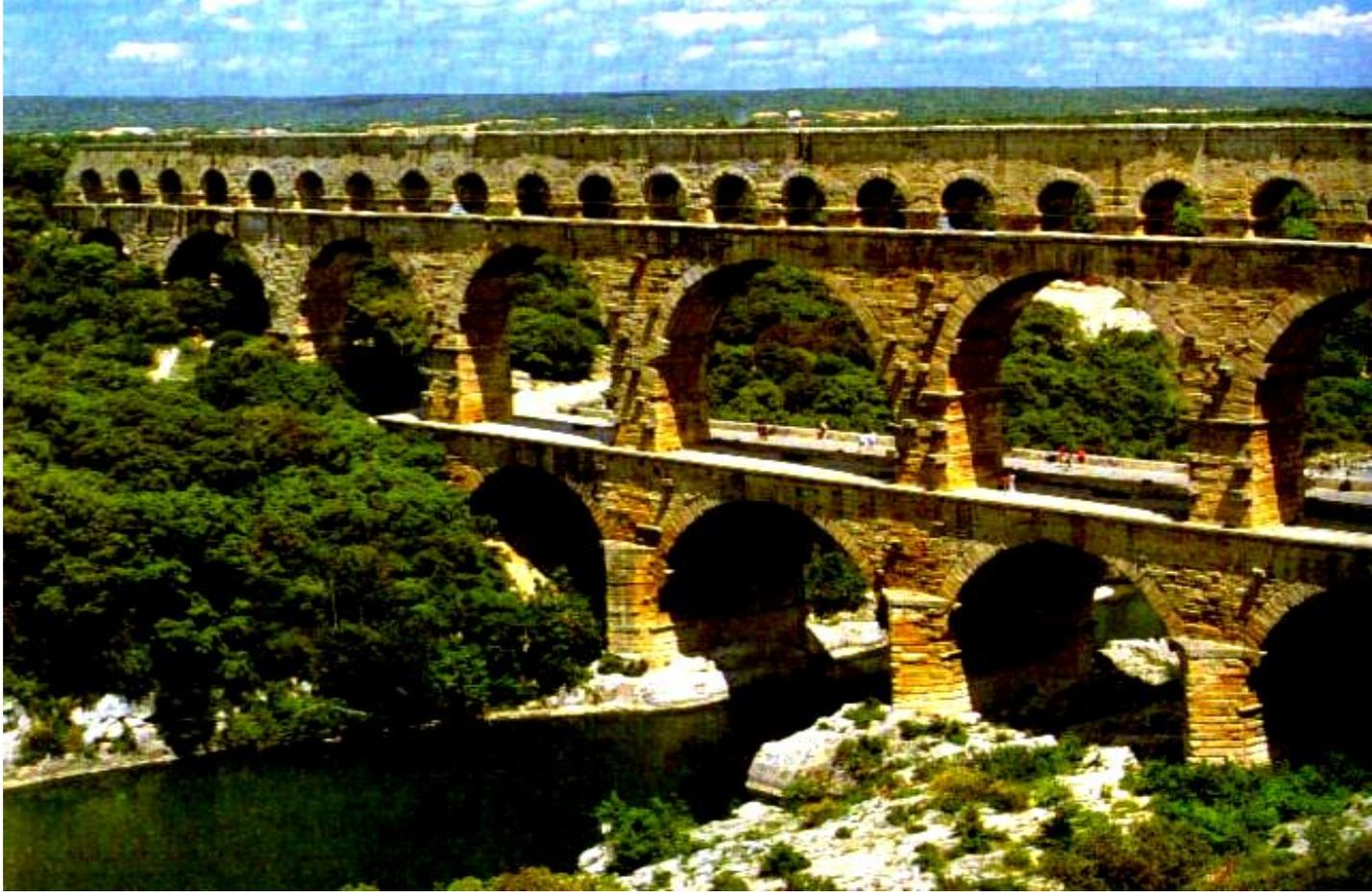
Для снабжения Рима водой строили водопроводы. **Акведук** - каменная труба, или кладка для подачи воды. Чтобы вода текла самотеком строились арочные опоры - **виадук** - арочный мост через реку, или ущелье.
