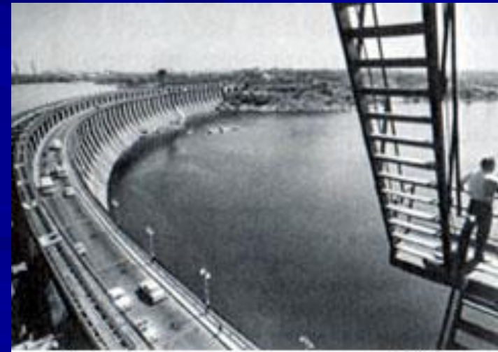
Восстановленная Днепровская ГЭС
