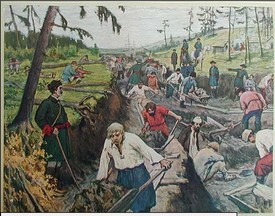
Прорытие Ладожского канала
