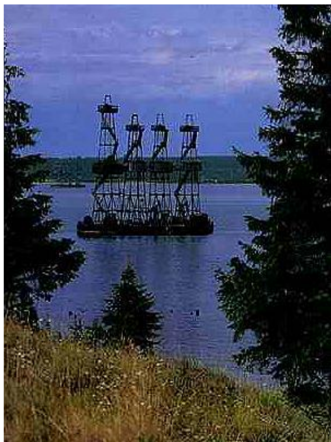
Нефтяные скважины в Поволжье.
