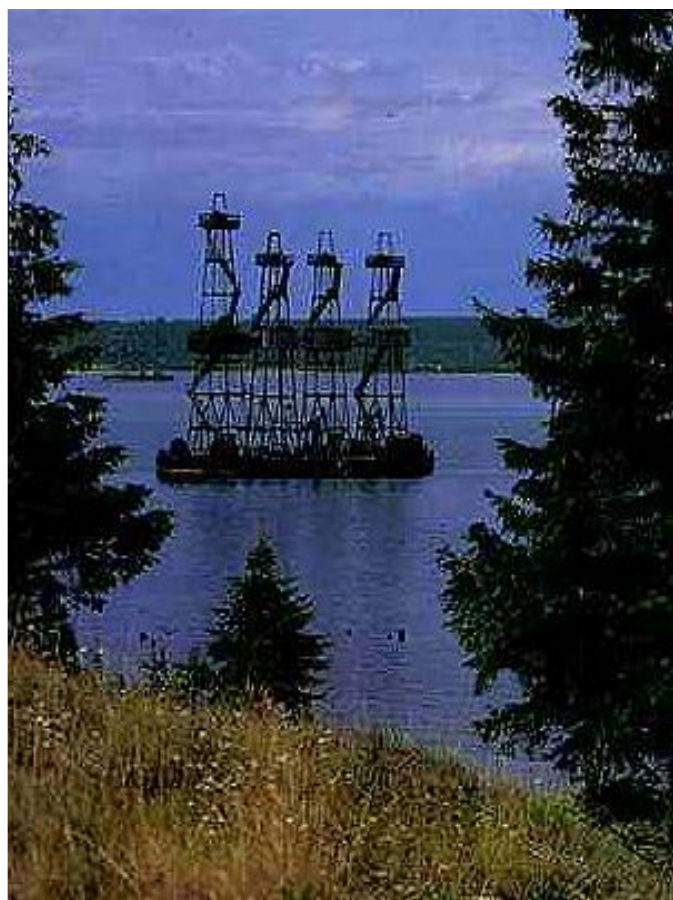
Нефтяные скважины в Поволжье.
