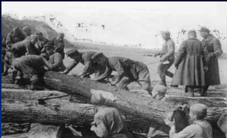
Возведение моста через Дон. 1942 г.
