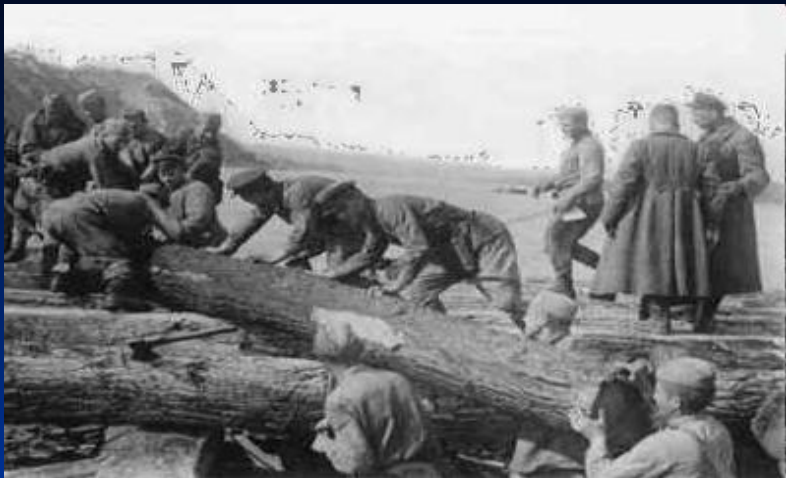
Возведение моста через Дон. 1942 г.
