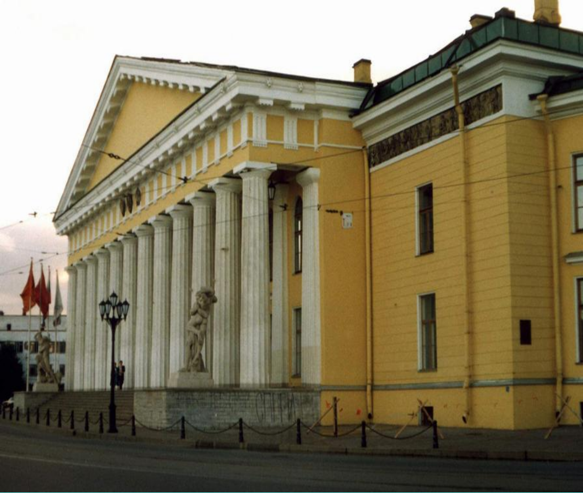
Здание Горного института (1806-1808) арх. А.Н.Воронихин
